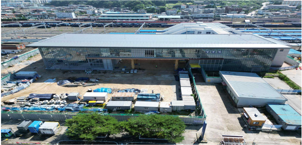
영주역사 신축공사 현황
